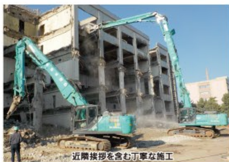
近隣挨拶を含む丁寧な施工
